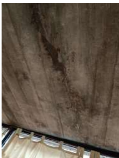
c- Filtraciones de agua
